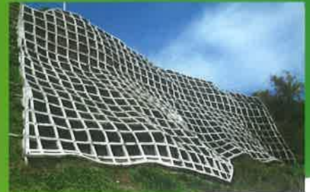
法面工事、治山工事
