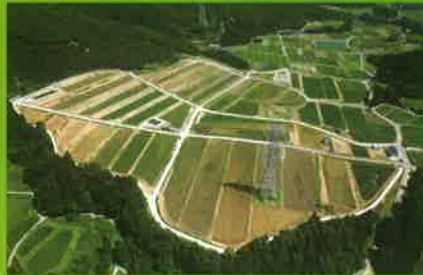
ほ場整備、農業用施設工事
