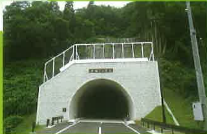
道路工事、トンネル工事、橋梁工事
